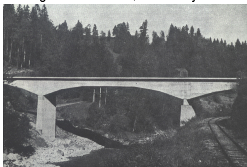
Abb. 11: Die alte Brücke zwischen Lingenau und Müselbach konnte im letzten Moment von den Widerstandsgruppen gerettet werden
